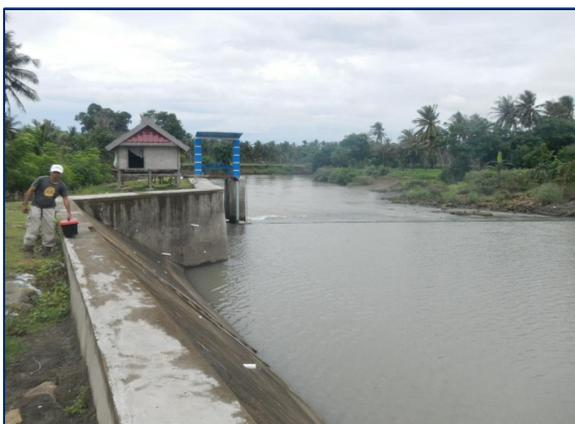
Gambar 3: Di bagian hilir Sungai Kelara dibangun sebuah bendungan untuk menahan laju kenaikan muka air laut.
