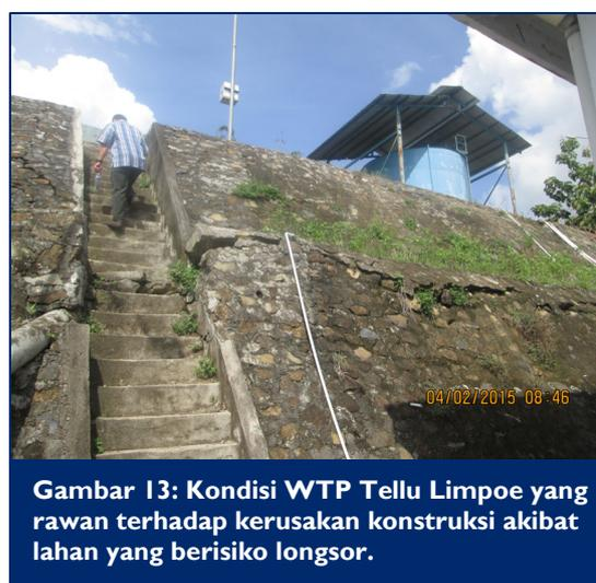
Gambar 13: Kondisi WTP Tellu Limpoe yang rawan terhadap kerusakan konstruksi akibat lahan yang berisiko longsor.
