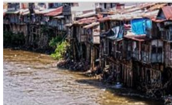
Gambar 3-3 Kondisi Bangunan di Bantaran Sungai Citarum
