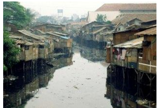
Gambar 3-3 Kondisi bangunan yang ada dekat bantaran sungai Citarum
