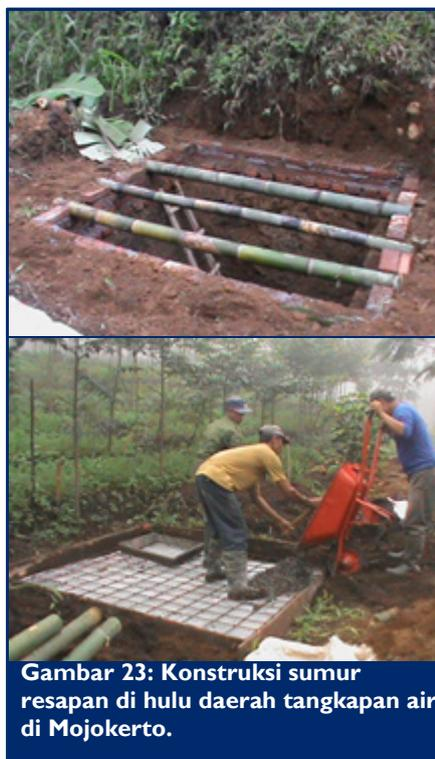
Gambar 23: Konstruksi sumur resapan di hulu daerah tangkapan air di Mojokerto.
